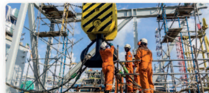
Ремонт и монтаж ЛЭП
